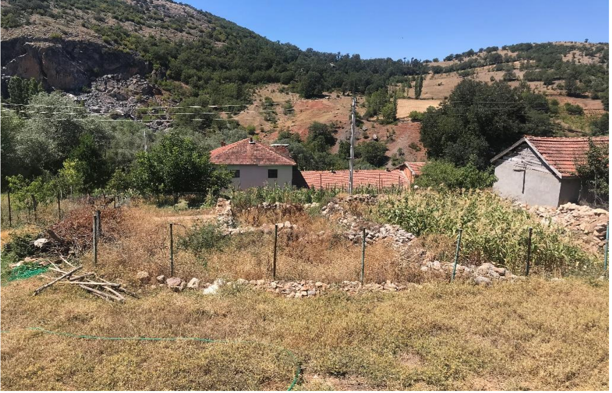
Şekil 2.25: Kaya düşmesi sonucu AMB kararı alınmış bölge (Kaynak: AFAD Arşivleri)
